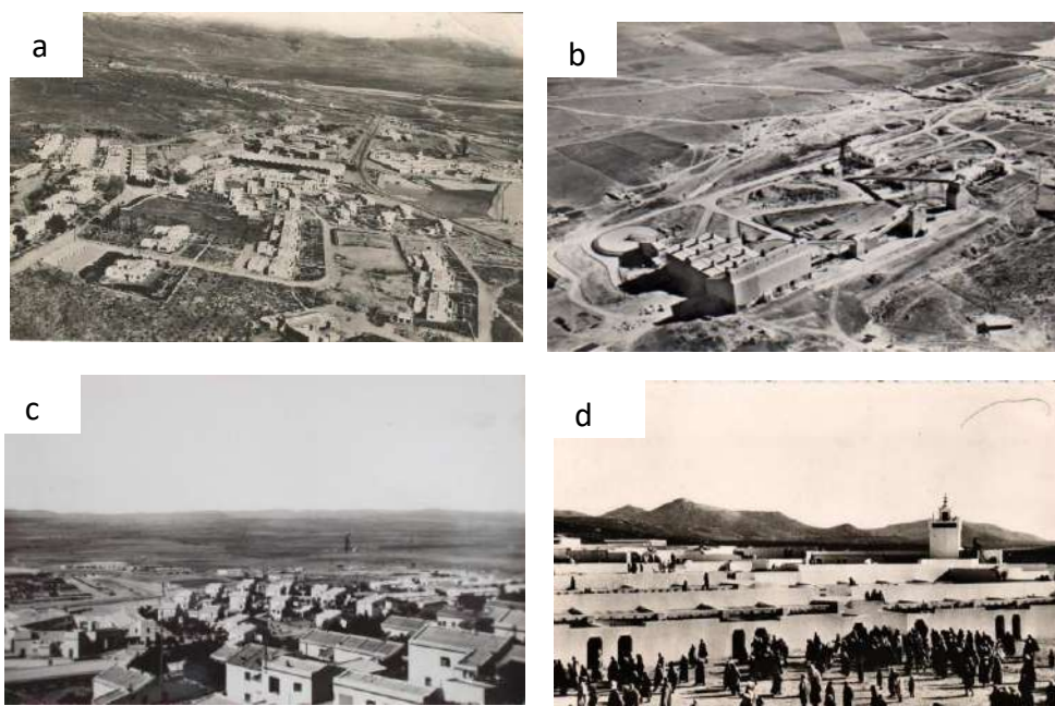
Figure 26 : Photos montrant le site de Sidi Boubker et ses installations et cités minières (a : vue aérienne du site, b : usine de traitement, c : cité minière des cadres et d : cité minières des ouvriers)
